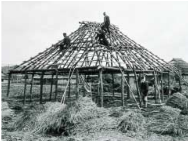
写真11 骨組みのようす（白老町：大正から昭和の初めごろ）
