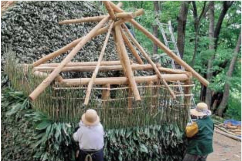
写真 15 ササで壁を葺いているようす
