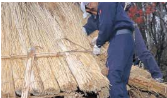
写真13 カヤで屋根を葺いているようす
