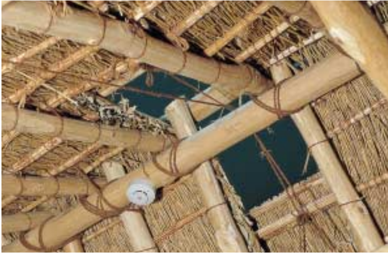
写真 17 天窓（内側から屋根裏を見上げたようす）
